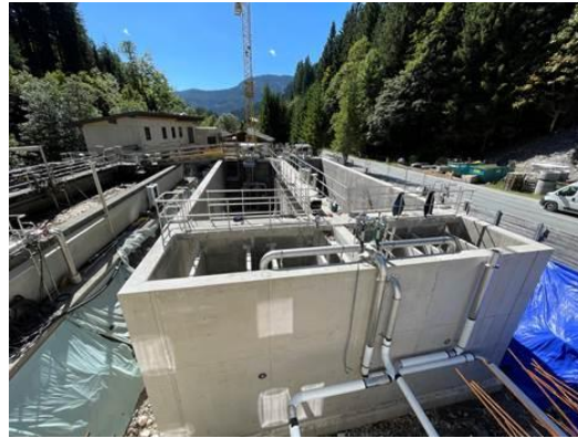
Abb. 4: Die beiden neu errichteten zusätzlichen Klärbecken mit maschineller Ausstattung
