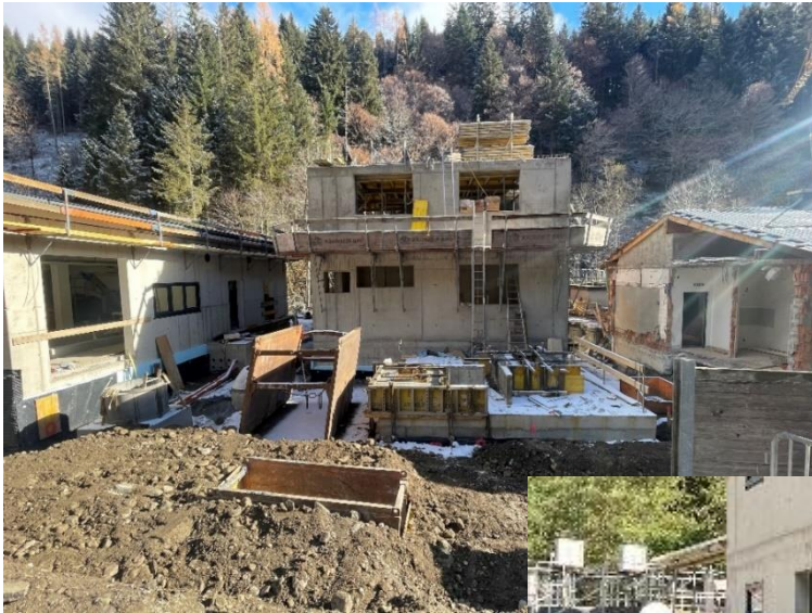
Abb. 4: Schalungsarbeiten an der OG-Decke des Betriebsgebäudes im November 2024
