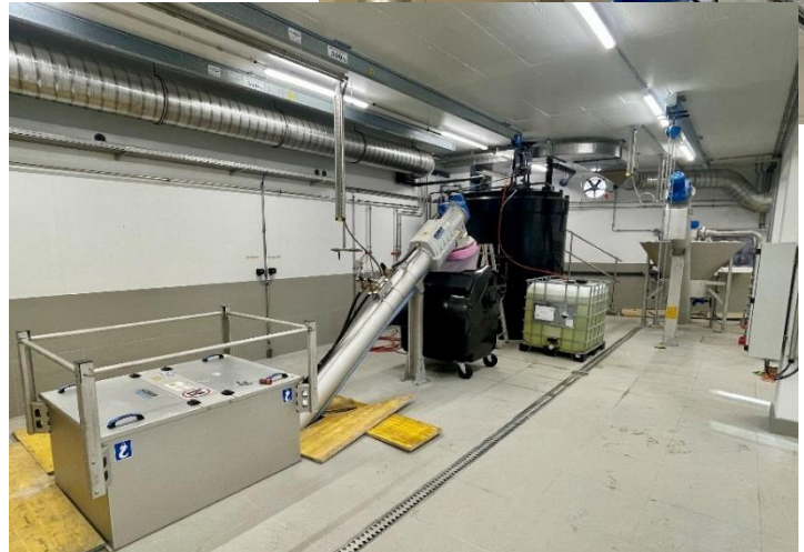
Abb. 5: Rechenhalle mit Zulaufgerinne samt Rechenanlage, Sand-/Fettfang mit Sandwäscher und Fällmitteltankanlage
